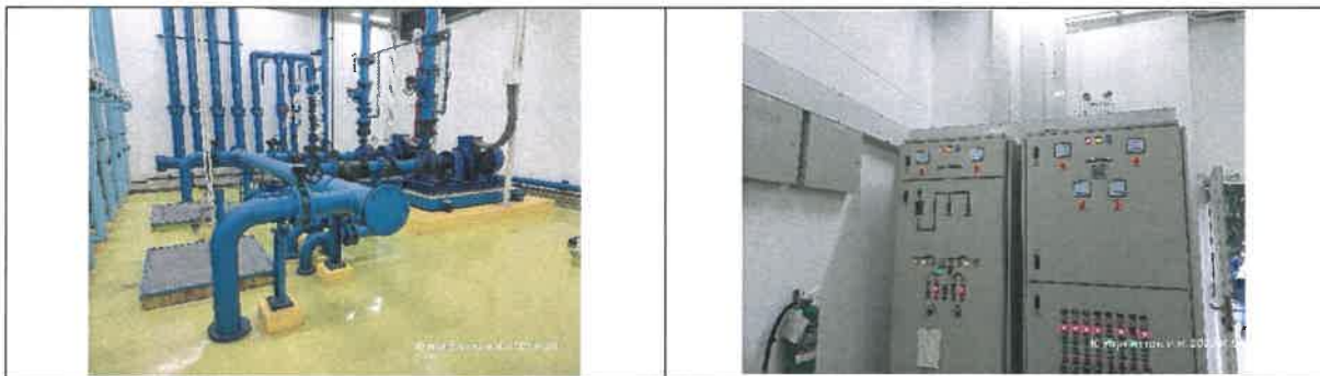
รูปที่ 18 ระบบสูบน้ำภายในอาคาร
