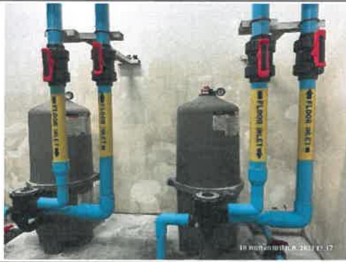
รูปที่ 85 ระบบกรองน้ำสระว่ายน้ำ
